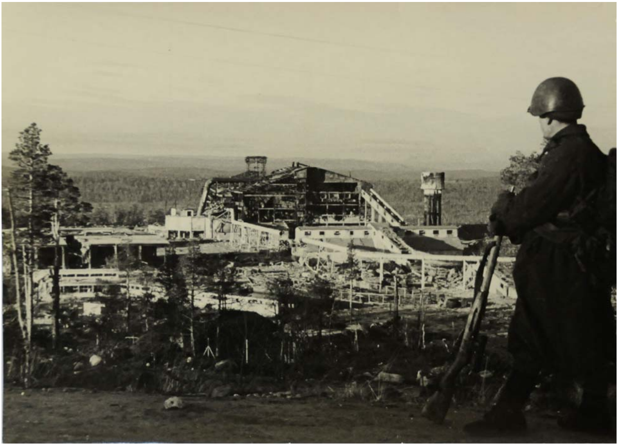
34. Разрушенный в ходе боев завод. Карельский фронт, г. Никель, [октябрь-ноябрь] 1944 г.
