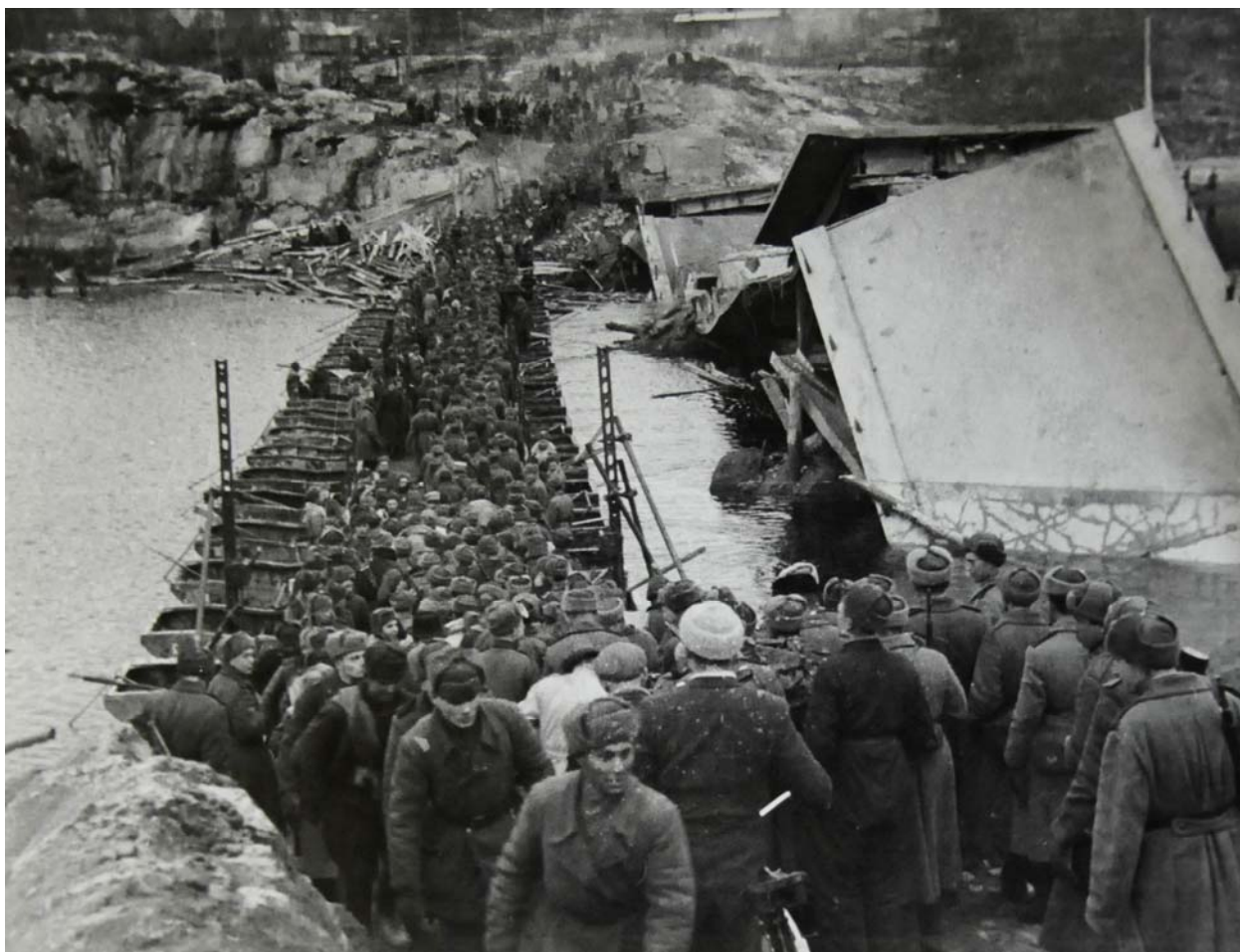
24. Вид разрушенного моста через залив у Киркенеса. Войска Карельского фронта на переправе. Норвегия, октябрь-ноябрь 1944 г.
